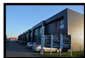
Voie du Testelet, Parc des Portes
