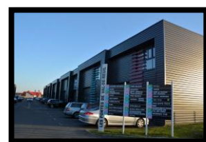
Voie du Testelet, Parc des Portes
